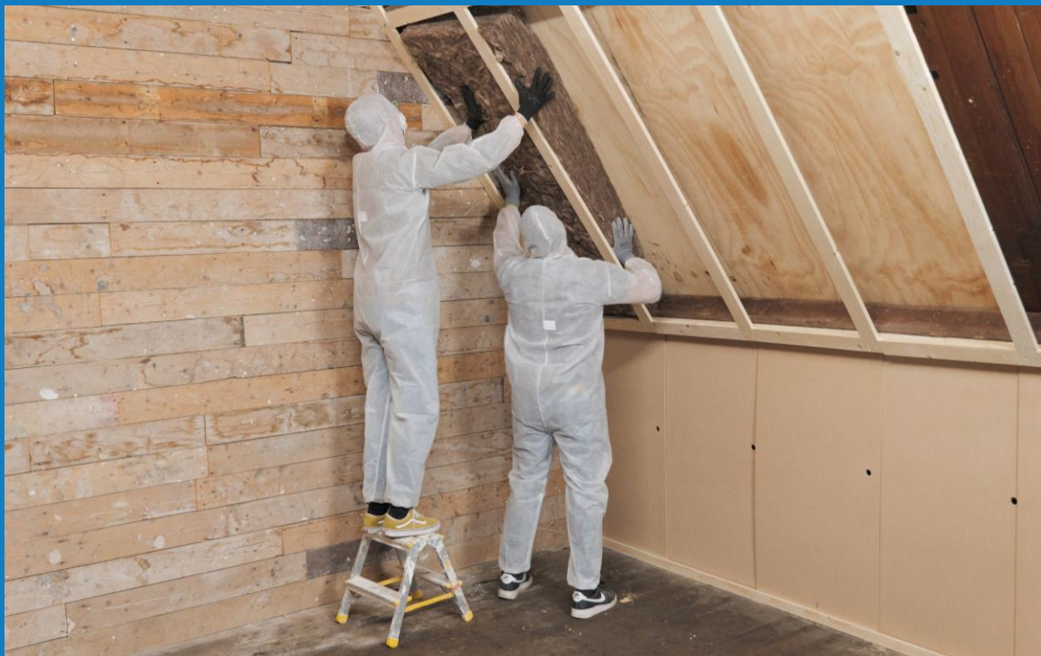
Schuin dak: isoleren van binnenuit
