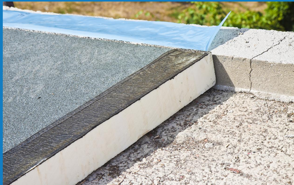
Plat dak: altijd isoleren van buitenaf
