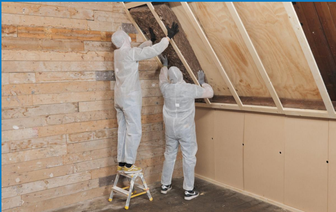
Schuin dak: isoleren van binnenuit
