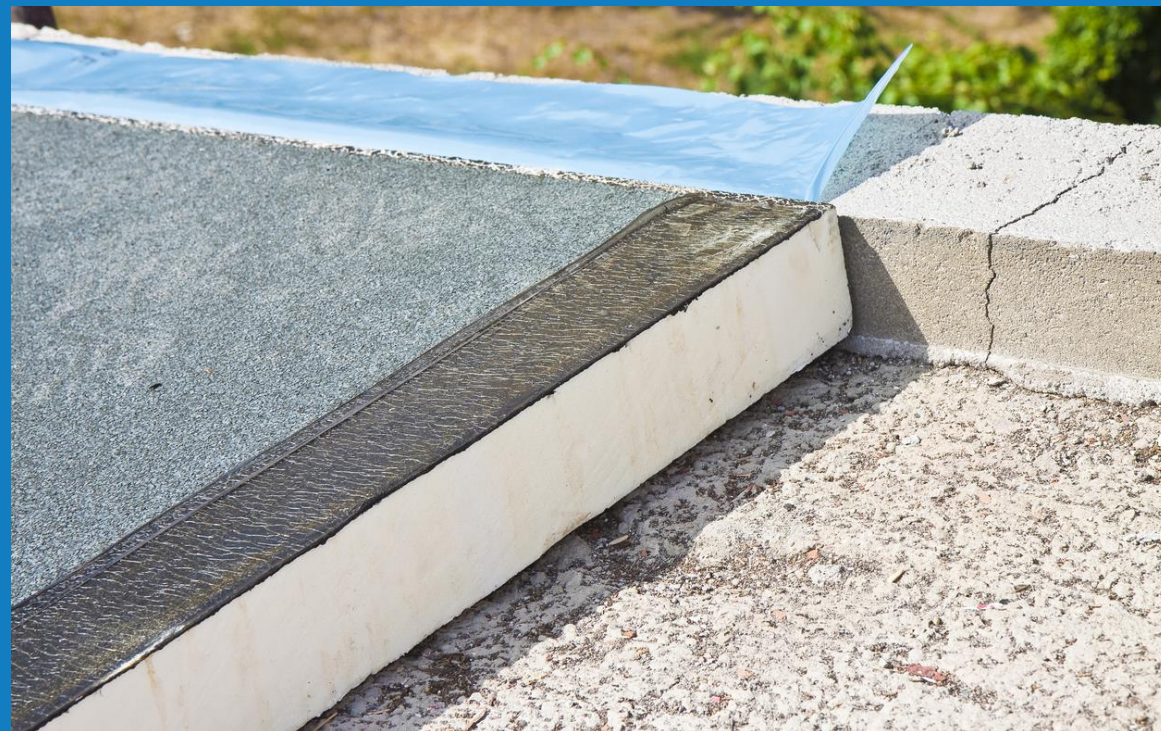
Plat dak: altijd isoleren van buitenaf
